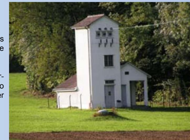
Rechts: Das Grundwasserpumpwerk „Weiher“ fördert pro Minute 1'000 Liter Trinkwasser zu Tage
