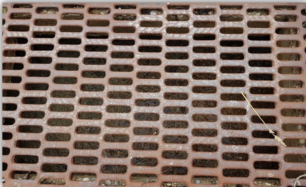
Abb. 50: Foto der Abdeckung des Güllelochs bei einem am Projekt beteiligten Landwirt
